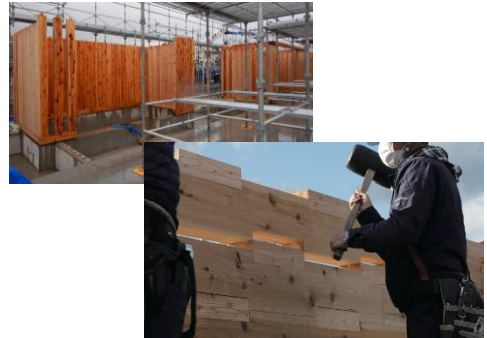
図2 縦ログ、重ね梁の施工
